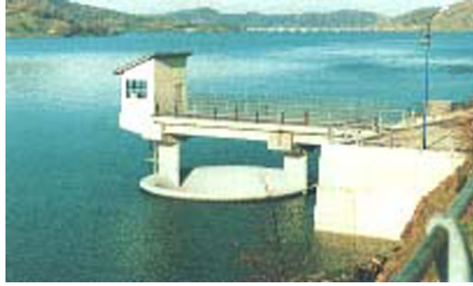
Figura 6-4: Sfiatore superficiale a calice del serbatoio di Campotosto.
